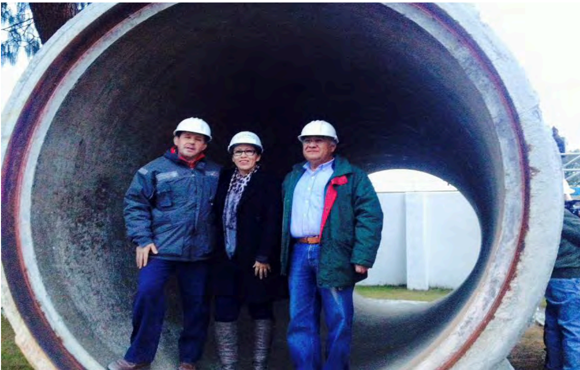
En recorrido al Sistema Cutzamala con servidores públicos encargados del abasto de agua a la Ciudad.
