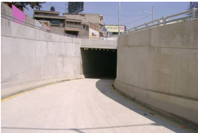
Paso vehicular inferior Acueducto
