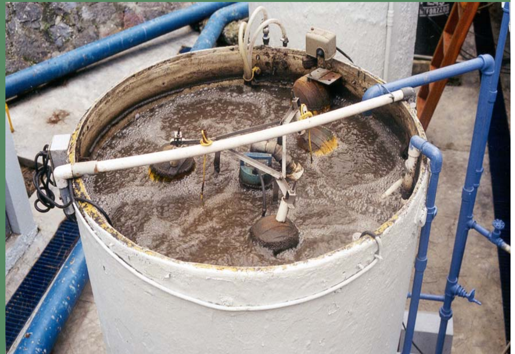
Reactor biológico que simula el tratamiento de lixiviados en un sistema de lodos activados de aguas residuales.
