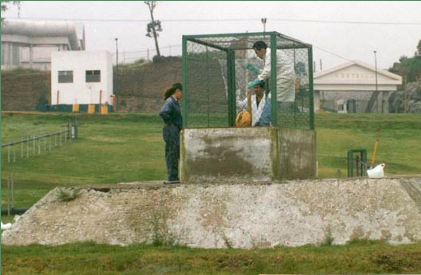
Pozo de monitoreo, Prados de la Montaña
