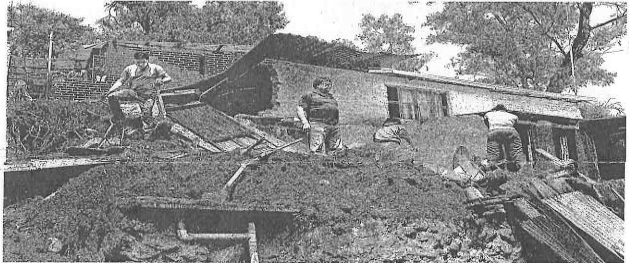
El deslave que se registró en Prolongación Río Mixcoac, casi equinoca con Alta Tensión, afectó varias viviendas sin que se registraran víctimas, aunque el señor José Israel (en la imagen), quien perdió parte de su patrimonio, comenta que alcanzó a sacar a su esposa a tiempo, no así a sus conejos.
