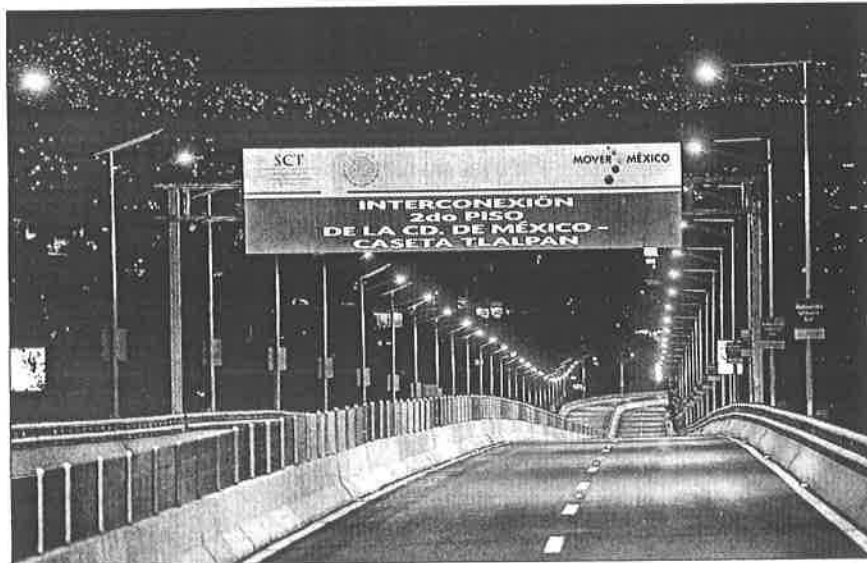
Este jueves serán abiertos a la circulación los siete kilómetros de cuota de la Autopista Urbana Sur. En la imagen, vista parcial del tramo construido por el gobierno federal ■ Foto Cortesía de la SCT
