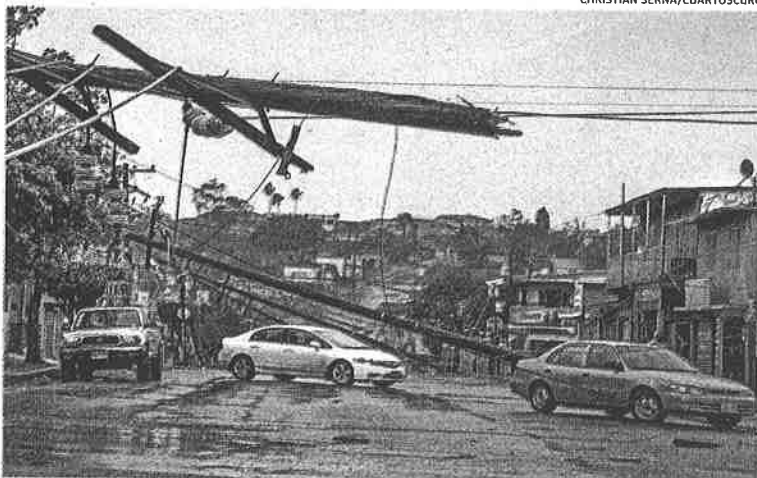
Las fuertes ráfagas de viento dejaron daños en varias partes de Tijuana.
