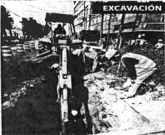
TRABAJADORES SIGUEN las labores para introducir el drenaje en la calle de Serapio Rendón donde tuvieron que rehacer uno de los registros, ya que presentaba fallas
