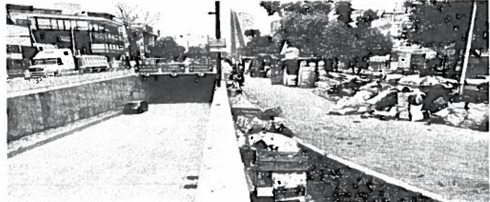
Mientras que la obra subterránea está concluida, en la superficie se realizan trabajos de limpieza y jardinería.
