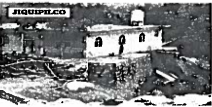
Pese a que cinco de las casas afectadas quedaron destruidas, no se reportan lesionados ni fatalidades.
