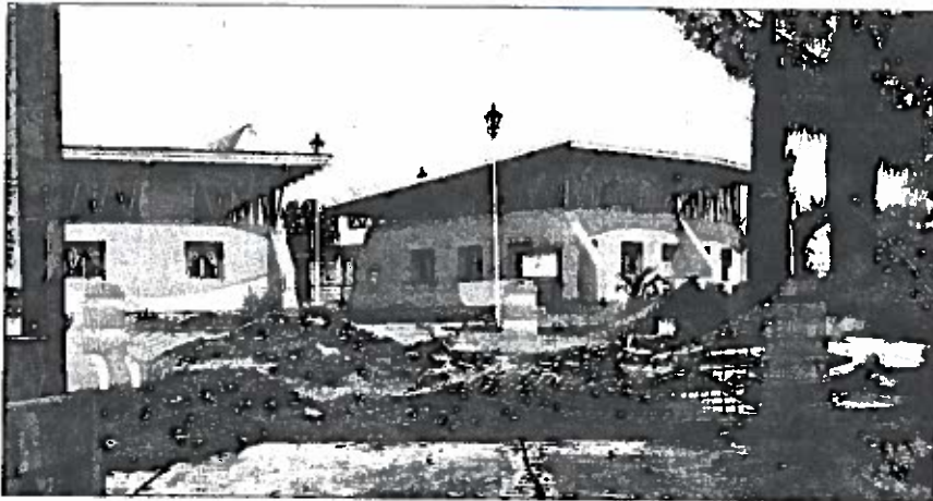
La Granja que construyó Clara Brugada en 2012 fue cerrada por la Profepa debido a que carecía de permisos.
