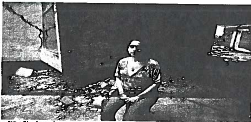
Serena Pérez ha sacado sus pertenencias por la ventana con ayuda de cuerdas, ante la incertidumbre sobre el futuro del edificio, que tiene daños estructurales. "Aunque me digan que se puede restaurar, me da miedo", dice.
