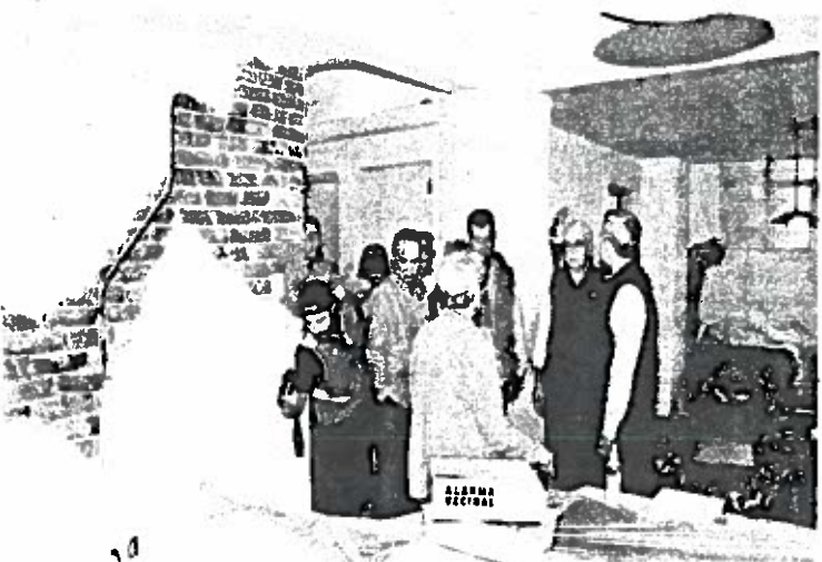
AUTORIDADES supervisaron los trabajos de rehabilitación que se realizan en el inmueble ubicado en Río Tigris 22, en la colonia Cuauhtémoc.
