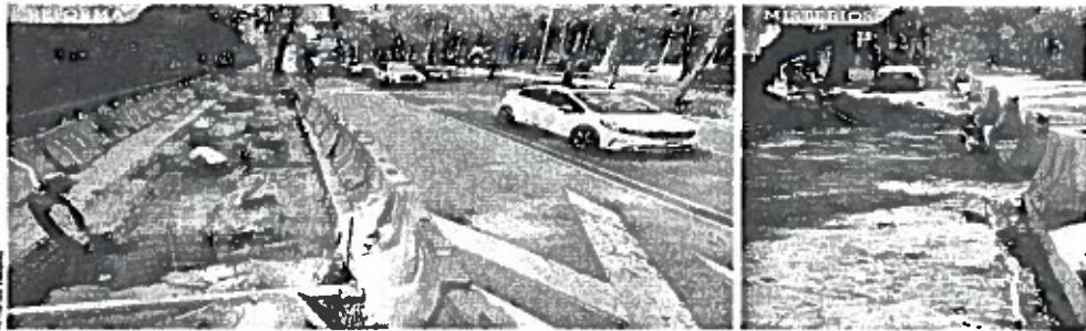
En distintos puntos aún se trabaja en la habilitación de los parabuses e instalaciones eléctricas.
