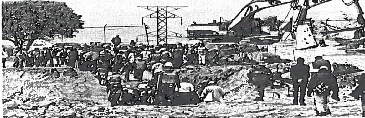
Los afectados por la construcción del tren Interurbano México-Toluca demostraron a representantes de la SCT y la CFE que las obras rebasan los 34 metros de longitud pactados; en ningún caso la contraparte pudo fundamentar el uso de más terreno.
