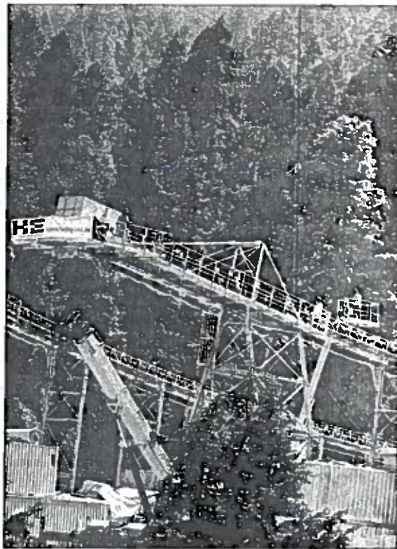
Aspecto de las obras del Tren Interurbano México-Toluca, a la altura del poblado San Lorenzo Acoptic, delegación Cuajimalpa ■ Foto Cuartoscuro
