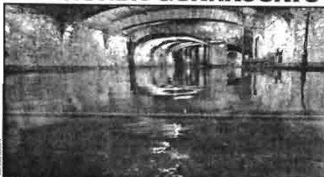
GUANAJUATO, Gto.- Se desbordó la presa La Olla por las fuertes lluvias. Bud produce aguaceros que afectan la zona del Pacífico y se adentrán.
