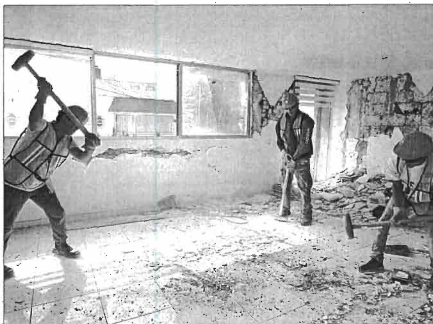
▲ Durante el inicio de los trabajos de demolición del edificio dañado durante el sismo de septiembre
