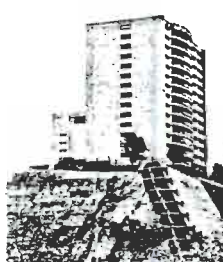
El 28 de octubre de 2015 se registró el primer desgajamiento del talud.
