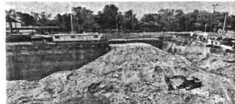
Vecinos de Coyoacán se oponen al proyecto inmobiliario que se desarrolla en Copilco 75.
